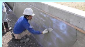
老朽化した水路壁のコーティング
