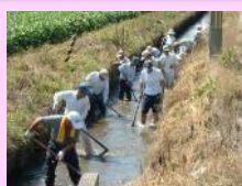
水路の泥上げ
