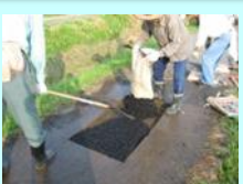
農道の部分補修
