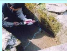
水路のひび割れ補修
